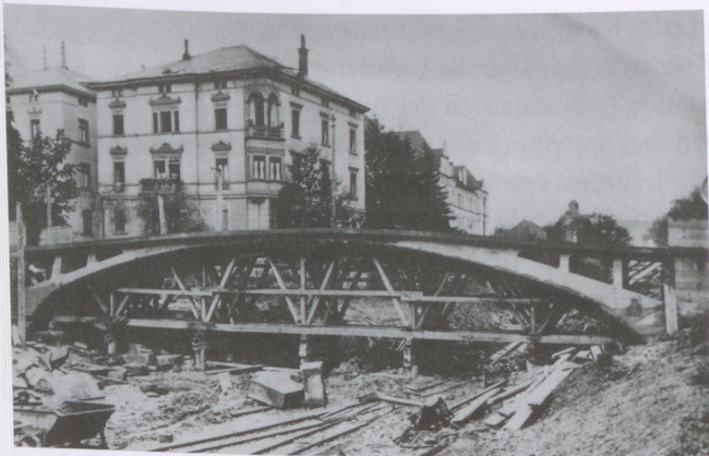
unten: Eisenbetonbrücke Tübingen (1911/13)
