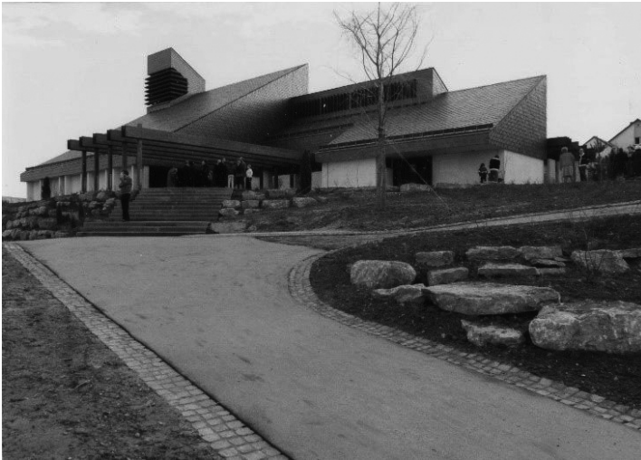
Für das Sakralgebäude auf dem Dagersheimer Friedhof wurde ein Architektenwettbewerb durchgeführt.
